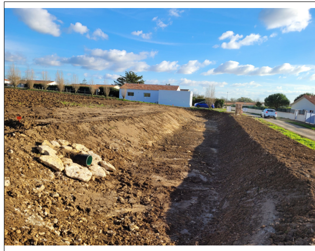
Vue du bassin d'eaux pluviales
